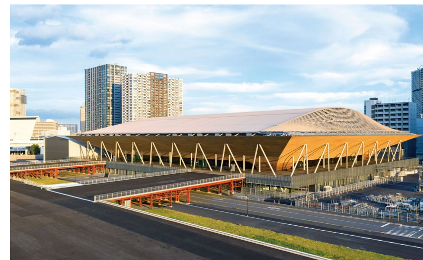
木造の大規模集客施設 (有明体操競技場)
